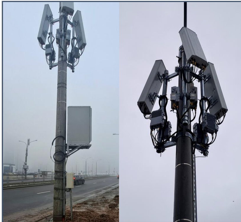
Рисунок 1.3 – Внешний вид ж/б опоры 15м (объект-аналог).
